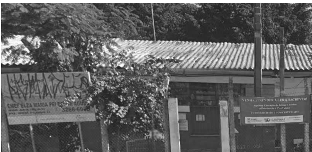
Figura 2 Aspecto geral da fachada da EMEF Profa. Elza Maria Pellegrini de Aguiar
